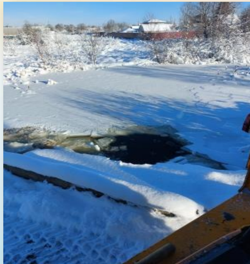
Зимнее содержание пожарных водоемов
